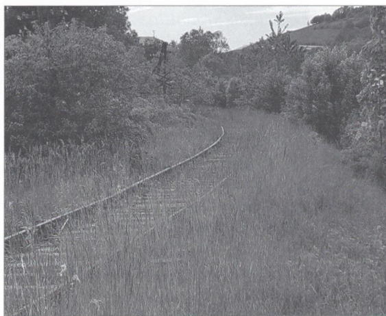
Stan infrastruktury kolejowej w Łososinie Górnej, 27 maja 2026 r.
