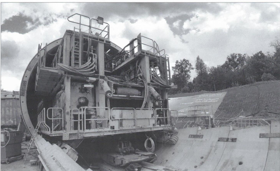
Elementy tunelu kolejowego T10: portal wschodni w Męcinie, gdzie rozpoczęto drążenie tuneli; wnętrze tunelu głównego; część maszyny TBM „Jadwiga” na portalu zachodnim w Mordarce
