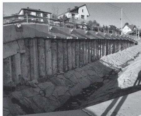
Przykład palisady wzdłuż wykopu ulicy Targowej w Limanowej, 3 maja 2026 r.
